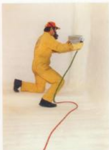
Εξομάλυνση επιφάνειας πολυουρεθάνης σε ψικτικό θάλαμο
