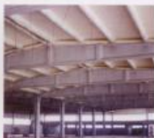
Μόνωση οροφής "ΕΥΡΩΕΚΤΥΠΩΤΙΚΗ Α.Ε." ΒΙ.Π.Ε. Κομοτηνής
