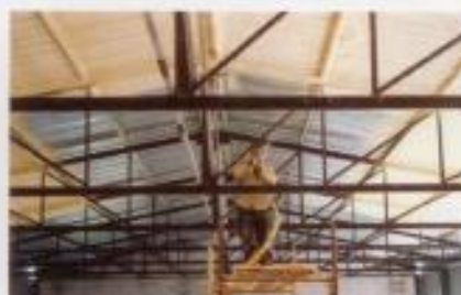
Μόνωση αυλακωτής λαμαρίνας σε πτηνοτροφείο
