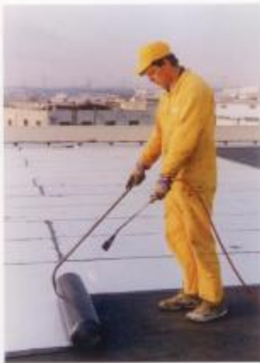
Επικόλληση ασφαλτόπανου με φλόγιστρο
