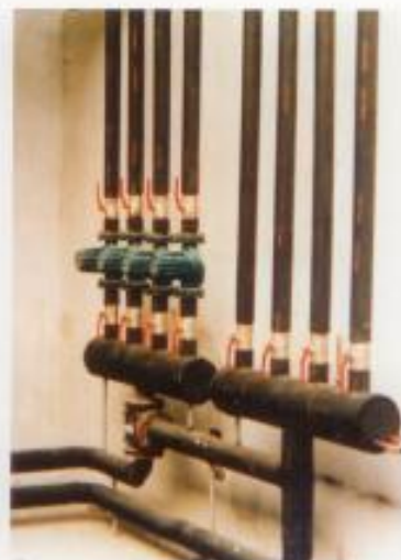
Μόνωση σωλήνων με ARMAFLEX
